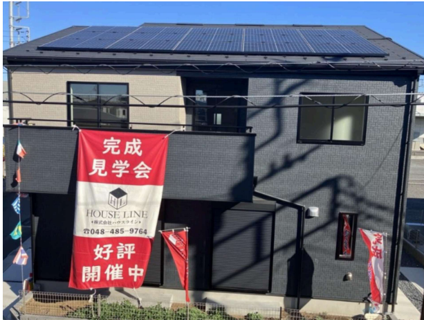
(写真) IGNITUREソーラーを採用していただいた住宅
